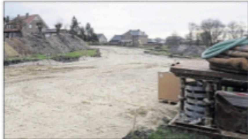
Die Tiefbauarbeiten am Neubaugebiet Am Berg in Esterwegen sind abgeschlossen. Foto: Niki Köppler
